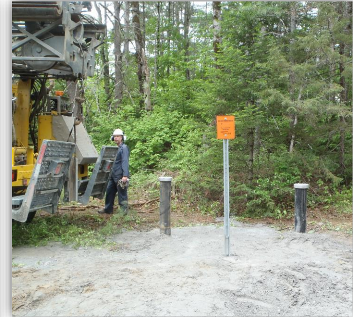
3. Finalisation de l'installation d'un puits
