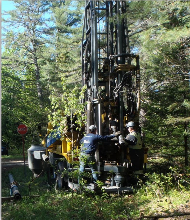
1. Installation de la foreuse
