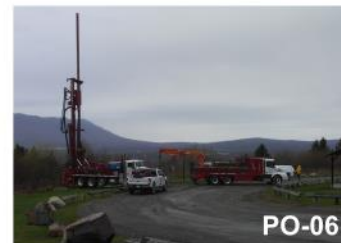
- Notre-Dame-des-Bois - Travaux de forage (MELCC - 17 mai 2019)
