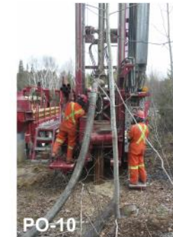
- Weedon - Travaux de forage (MELCC - 15 mai 2019)
