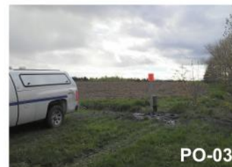
- Compton - Puits finalisé et équipé (MELCC - 21 mai 2019)
