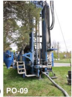
- Val-Joli - Travaux de forage (COGESAF - 23 mai 2019)
