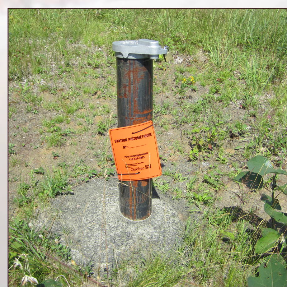
Figure 1: Puits d'observation PO19
