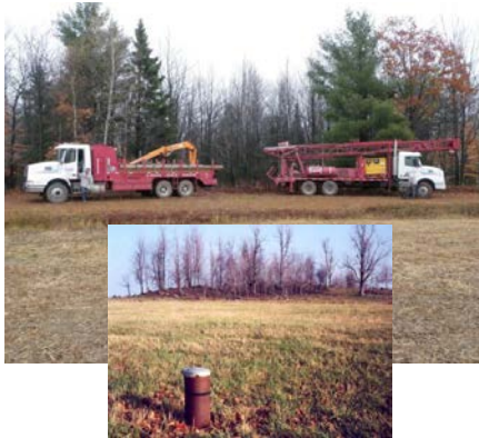
Forage au roc
