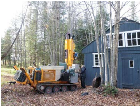
Forage CPT (installation de piézomètres)
