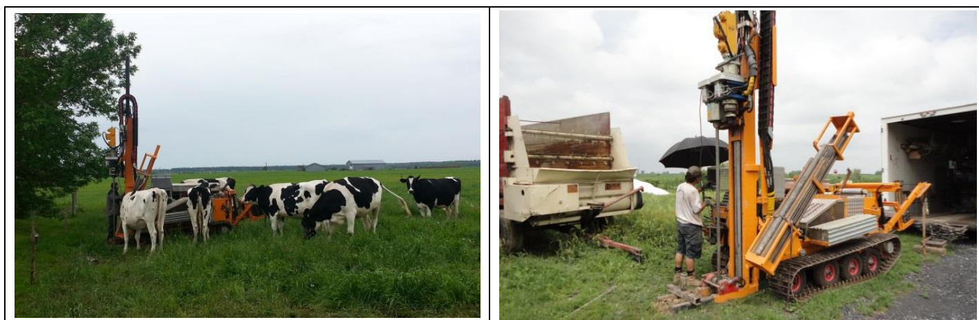
Figure 2.3 : Travaux de forages avec la foreuse Geotech 605D de l'INRS
