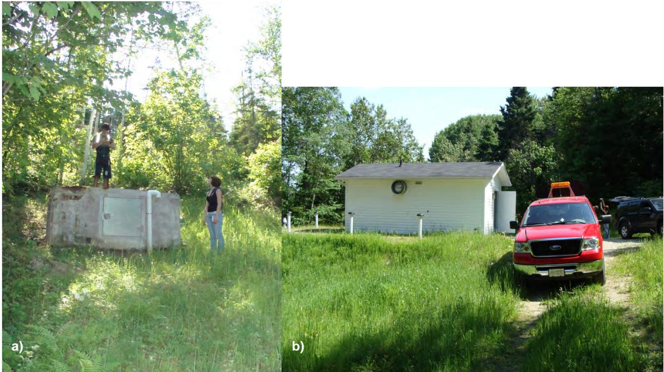
Figure 7-3 : Captage de résurgence à Saint-Urbain; a) exemple de caisson de béton qui confine l'eau de resurgence avant qu'elle soit acheminée vers la station de distribution (b) quelques mètres plus bas.
