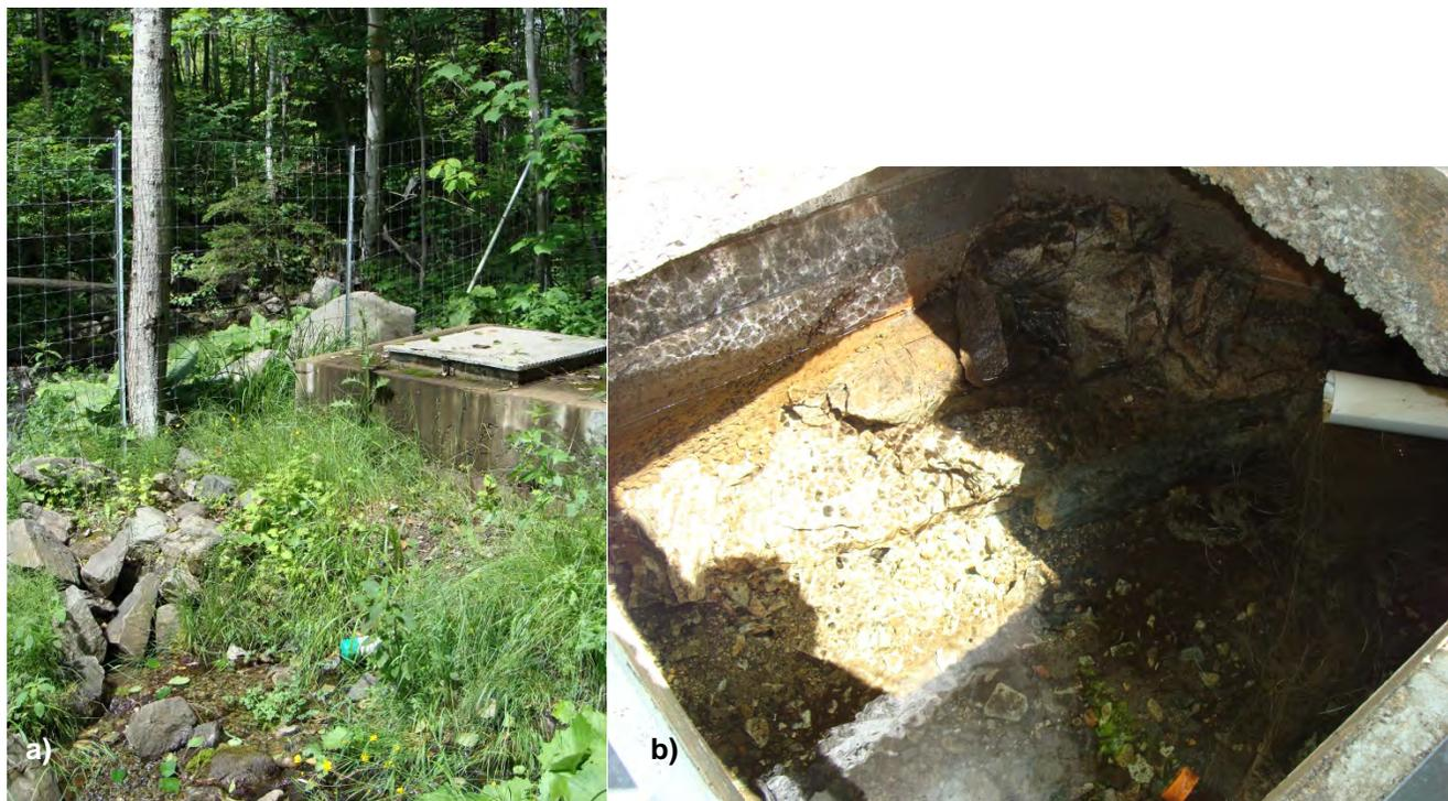
**Figure 7-2 : Installation de captage de la résurgence dans un caisson de béton (a) et vue de l'intérieur du caisson avec les tuyaux d'amenés d'eau (b).**
